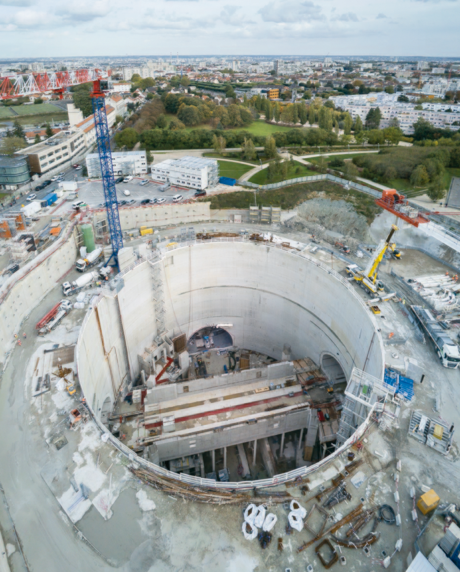
A la gare Villejuif-Gustave-Roussy, un pont roulant monumental est construit afin de permettre au tunnelier de la ligne 14 sud de passer au-dessus de celui de la ligne 15 sud. Le croisement des deux tunneliers aura lieu entre décembre 2019 et avril 2020.
